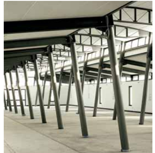
Das neue, aufgestockte Obergeschoss heute
